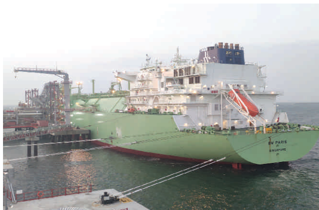
Indian Oil LNG Terminal
